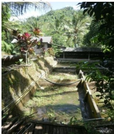
Gambar 4.1 Pepohonan rimbun dan Kondisi kolam rusak
