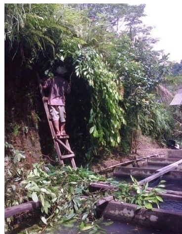
Gambar 4.2 Perbaikan dan pembersihan kolam yang rusak
