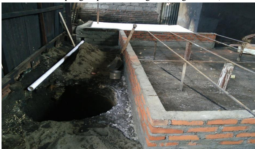
Gambar 3. Bak pengasapan, pencucian ikan dan saluran limbah pembuangan milik kelompok Bpk.Taher.
