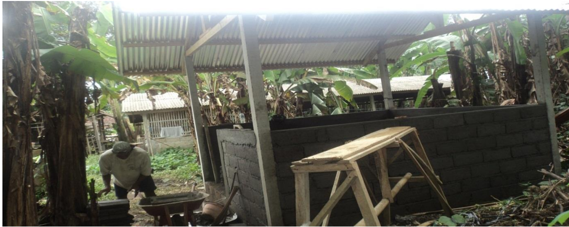
Gambar :1. Bangunan untuk pengolahan kompos ketika dalam proses penyelesaian
