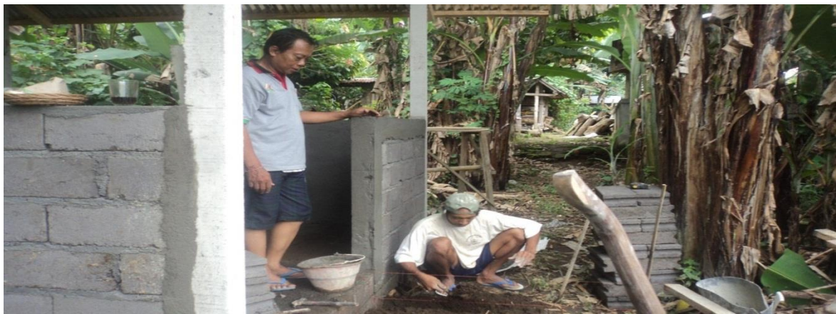
Gambar 2. Tim pelaksana mengawasi pengerjaan bangunan
